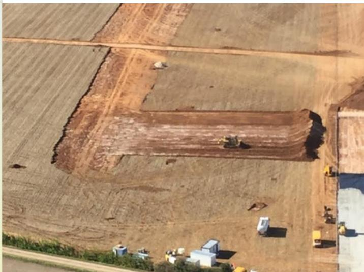
Dans les prochaines semaines, si tout continue ainsi, le chantier risque d'être progressivement excavé par une cohorte de tractopelles et verra ses environs quadrillés de 18 km de canalisations. Viendra enfin le pompage, 615m<sup>3</sup>/heure d'eau pompée pendant 45 jours 24h/24 pour arriver à l'une des plus grandes bassines construite en France avec pas moins de 720 000 m<sup>3</sup> d'eau stockée.
