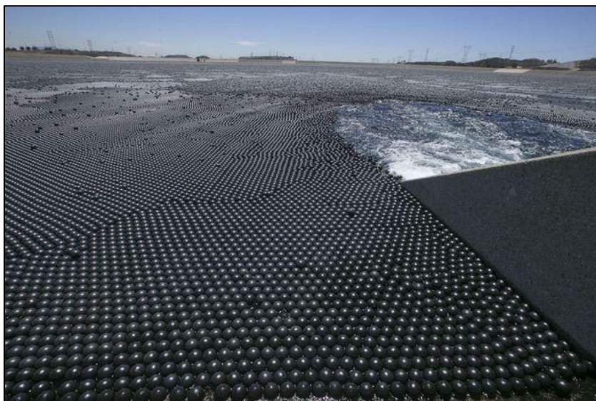
Shade balls sur un réservoir à Hollywood (Los Angeles)
